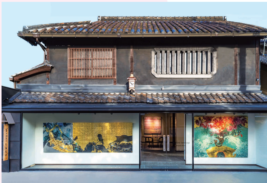
明治期に建てられた町家を改装したギャラリーためなが 京都店
