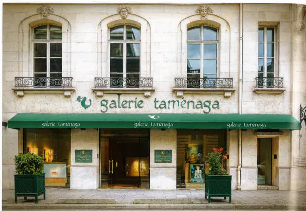
La façade de la galerie Tamenaga située avenue Matignon, dans le huitième arrondissement de Paris.
